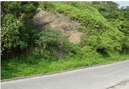
圖七 觀察地層和邊坡的傾斜是否同向，就可以發現何處為順向坡
