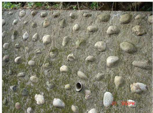
圖九 駁坎的排水管排水
