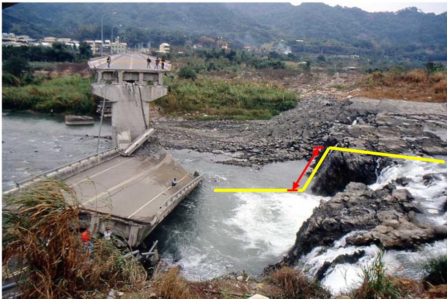
圖十一、921 集集地震期間，車籠埔斷層在台灣中西部埤豐橋造成地表破裂後所形成的斷層崖（紅色箭頭）。
