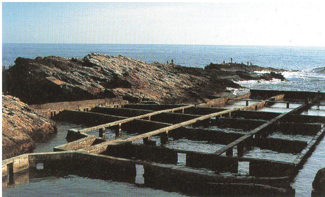
照片 25：和美地點的海岸平台常被開挖成九孔養殖池。
