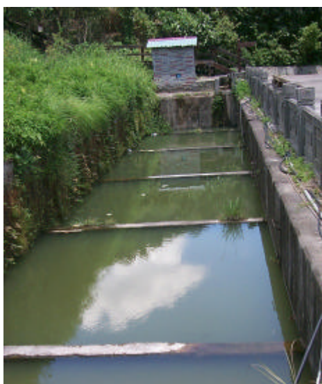
圖(十二)125平台北側有沉砂池，可減少進入兩條溪流中的砂石含量。
