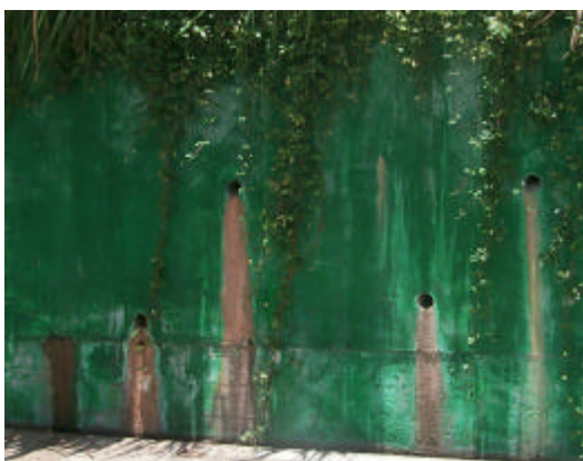
圖(十五)水泥護坡上都設有排水管，以維持良好的排水，防止內部水壓過高，造成坡面破裂。
