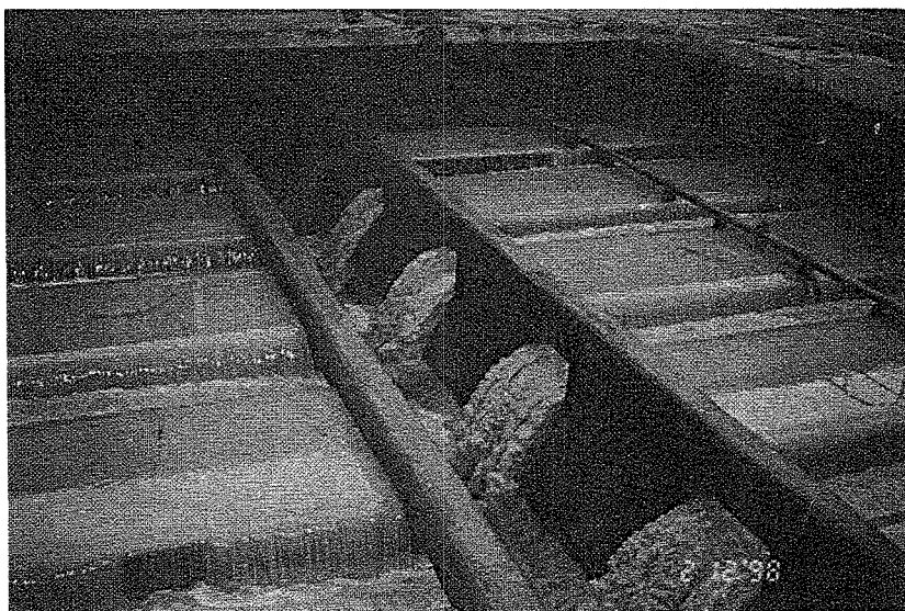
圖一 反沖洗過程中，濾砂與濾石間附著的雜質、泥質被沖出。
