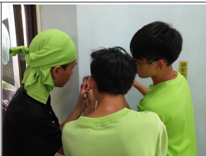
說明：鑽洞壁掛安裝
