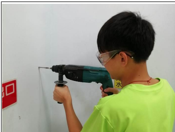
說明：電鑽使用
