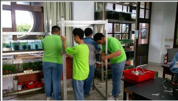
說明：大型系統缸角鋼安裝
