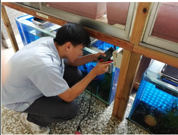
說明：搬遷後安裝，重新安裝插座
