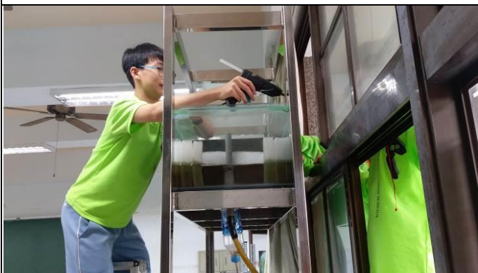
說明：學生在過濾槽上打熱熔膠固定
