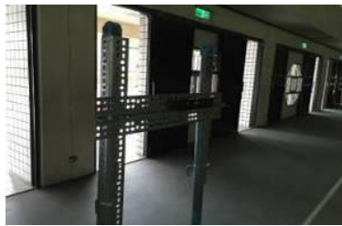
1.先利用角鋼和羽球架固定成U字型
