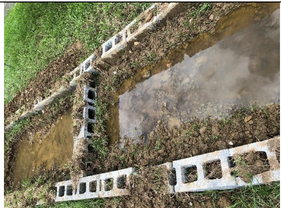
土壤改良向下挖至不透水層
