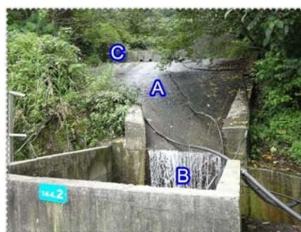
2. 蘇花公路 144.7K(無名橋)：本景點主要介紹護坡工程類型與瀑布地形，包含了三個觀察重點：(1) 駁坎磚與重力式擋土牆的比較：A. 駁坎磚類別為坡面保護工，目的為防止山坡風化。B. 重力式擋土牆類別為擋土護坡工，目的為防止山坡崩塌。C.
