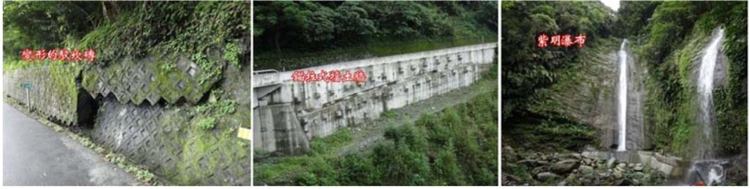
7. 蘇花公路 151.9K(一路通餐廳)：本景點有大規模的崩塌區，觀察重點為：(1) 擋土牆與防落石網：落石堆的土石到了某個角度時就不再滾動了，這個角度稱為「安定角」，教學重點為引導孩子認識：安定角愈大愈危險。而此處複合式防災設施包括了重力式擋土牆與防落石網，能發揮的效用包括了：擋土牆能保護邊坡，避免崩塌；防落石網能攔阻跳動的落石破壞道路；輪胎能降低落石的撞擊力量；削坡整形能減低落石堆崩塌的機率。
