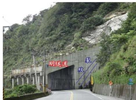
了阻擋落石，避免造成往來車輛、人員的傷亡。以前的明隧道頂部是平坦的，上面擺放輪胎，減輕落石撞擊力量；現在的明隧道頂部是傾斜的，以便讓落石滾下去，延長明隧道的使用年限。我們可觀察明隧道的壁面出現許多同方向的裂紋，為剪力所造成，代表此處明隧道快要壞掉了。(2) 噴漿：噴漿是利用噴漿機將混凝土噴到山壁上，可以防止岩石風化、剝落，適合施作於岩石表面，優點是施作的坡度沒有限制。此處噴漿剛好噴到一半，我們可以觀察到坡面有縱橫交錯的鐵絲網增加強度，現場還可聞到刺鼻的雞屎味，因為混凝土內加入雞屎(肥料)可使植物長得很快，經過二、三個月就一片綠意了。另一方面，沿途可見野溪噴漿，但其效益容易被土石流所掩埋，徒勞而無功。
