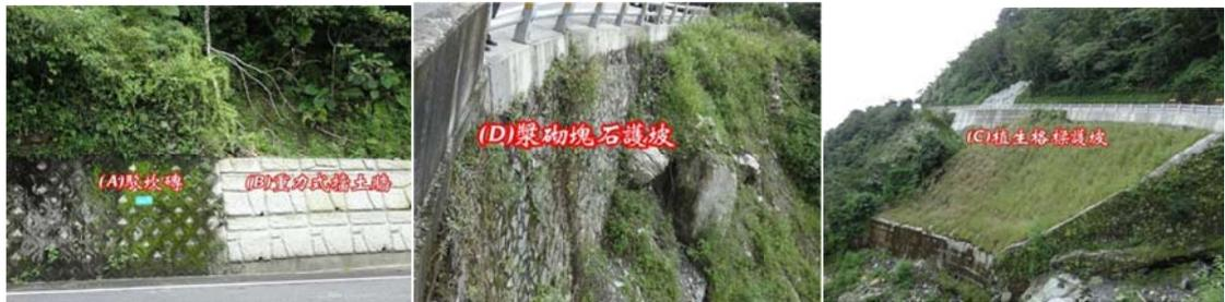
3. 蘇花公路 147K(第二觀音橋)：本景點主要介紹災害與防災設施的補強以及岩石構造的思考，包含了二個觀察重點：(1) 土石流與掛鐵絲網：河床土石流的特徵：巨礫、大礫為主，角礫為主，石塊排列無方向性，河床已被堵塞。可與孩子討論如果再度降下豪大雨的話，將會再度發生更嚴重的土石流災害。而在另一側的崩塌區工程單位正在掛鐵絲網，掛網的功效為防止落石掉下來。(2) 岩石構造：河床上的石頭裡出現凸鏡體、剪裂構造等變質構造代表岩石受到長時間的作用力、岩石受到高溫的作用、岩石受到應力的擠壓、岩石受到高度變質的作用等意義。
