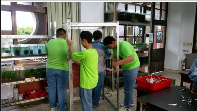
說明：大型系統缸角鋼安裝
