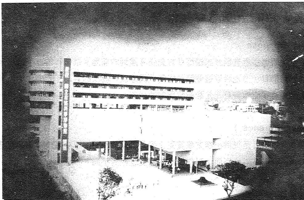
圖一 國立自然科學博物館第一期建設中的太空科學劇場設施
